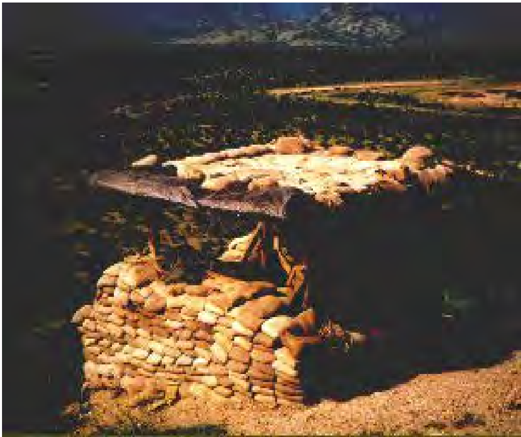
9) above. Atop NUI DAT HILL.
