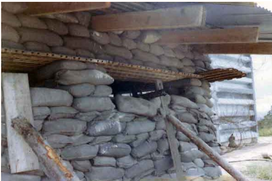
2a. Đà Lạt Radar Station, Bunker and M60. 1967.
